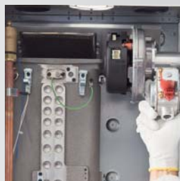
Apertura sistema combustione completo
