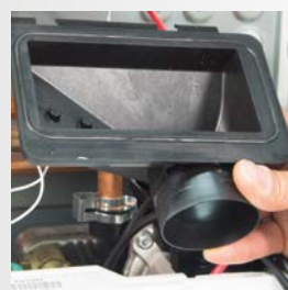
Ispezione raccolta condensa
