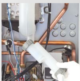
Rimozione sifone condensa
