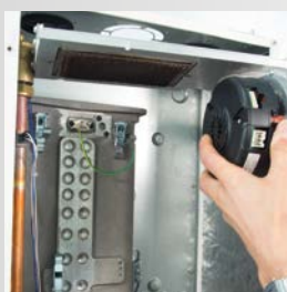
Rimozione del sistema di combustione completo
